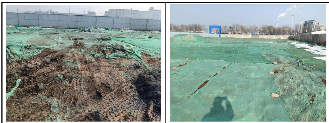
图 2-4 开工前现场照片
