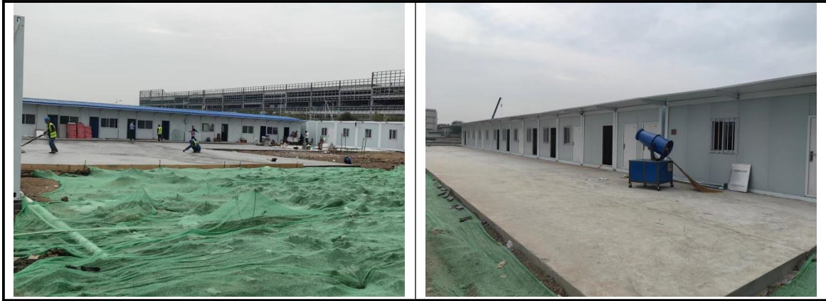
图 2-3 施工生产生活区现状照片
