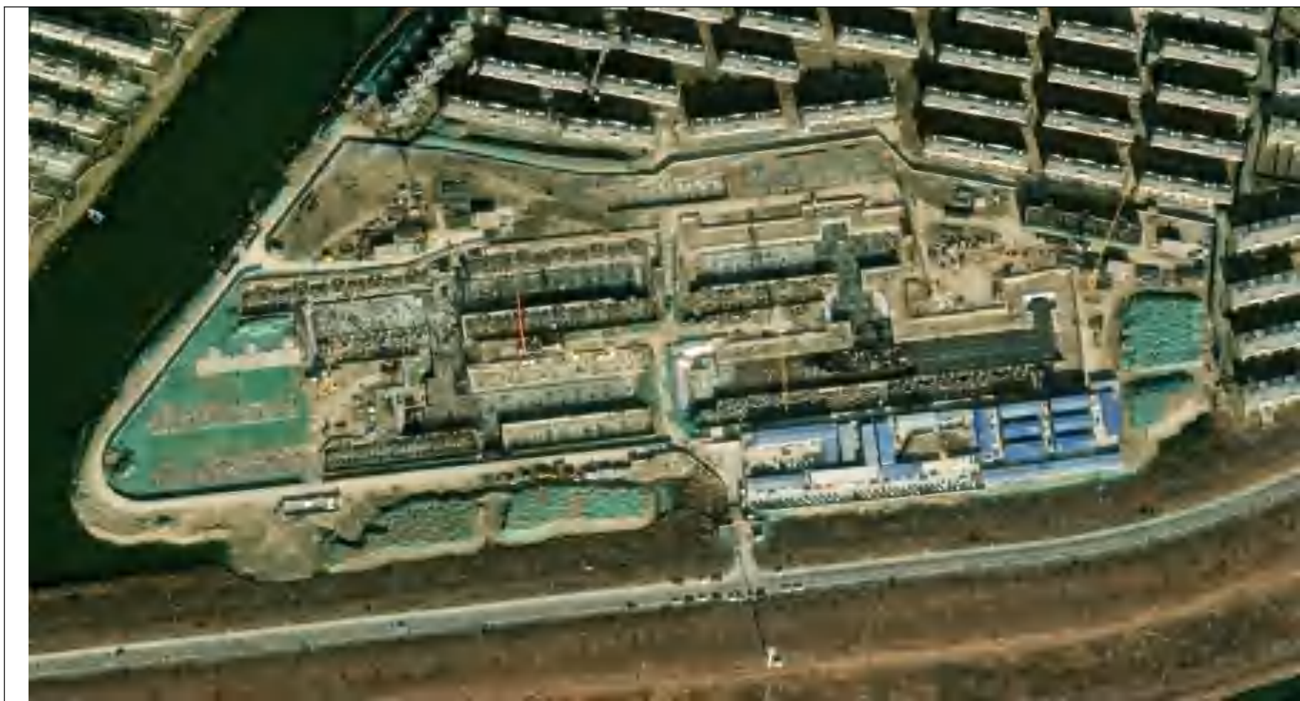
项目建设中影像图
